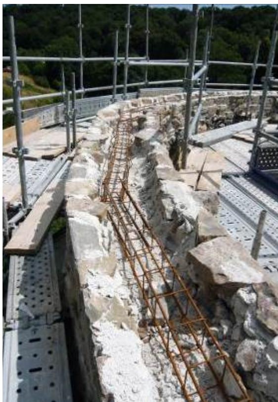
Réalisation d'un chaînage sur le faitage
