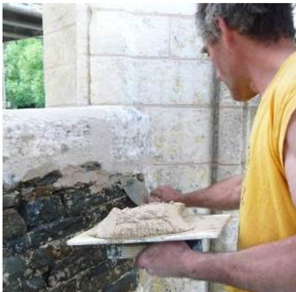
Réfection des joints au mortier de chaux
